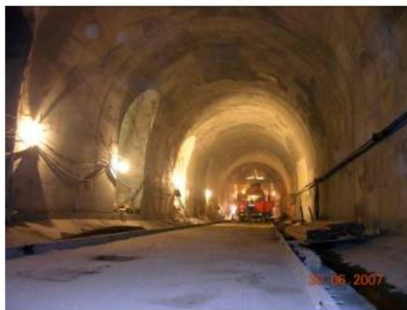
12-сурет – Өздігінен жүретін станциялық қалыптау және бүйірлік станциялық туннельдерді тұрақты қаптау
