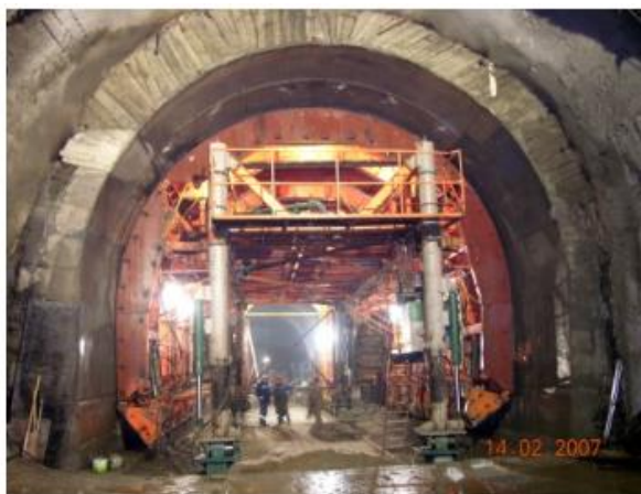
12-сурет – Өздігінен жүретін станциялық қалыптау және бүйірлік станциялық туннельдерді тұрақты қаптау
