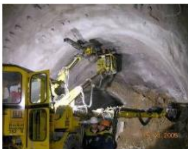
11-сурет – Atlas Copco Rocket boomer 352 S қондырғысымен қорғаныс экраны құбырларын бұрғылау
