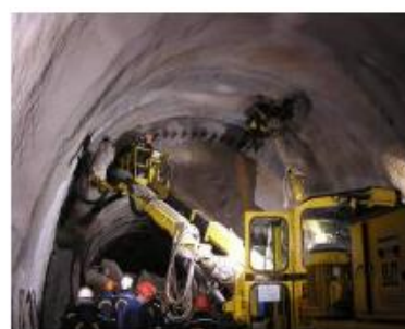
11-сурет – Atlas Copco Rocket boomer 352 S қондырғысымен қорғаныс экраны құбырларын бұрғылау
