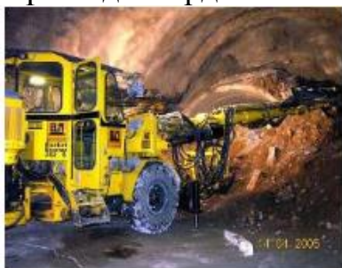
11-сурет – Atlas Copco Rocket boomer 352 S қондырғысымен қорғаныс экраны құбырларын бұрғылау
